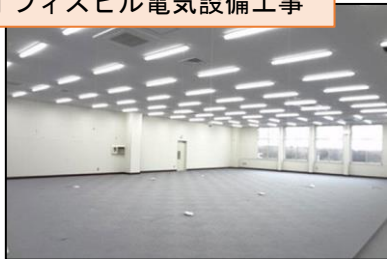
オフィスビル電気設備工事
