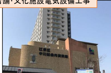
店舗・文化施設電気設備工事
