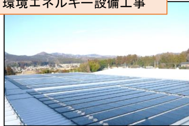
環境エネルギー設備工事
