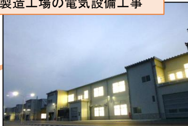
製造工場の電気設備工事
