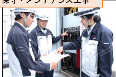
保守・メンテナンス工事
