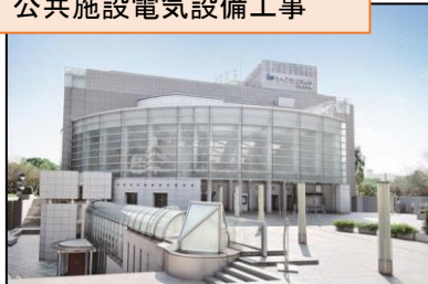
公共施設電気設備工事
