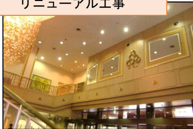
リニューアル工事
