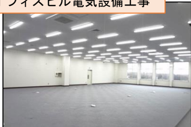
オフィスビル電気設備工事
