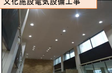
文化施設電気設備工事
