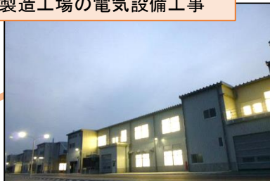
製造工場の電気設備工事
