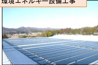
環境エネルギー設備工事
