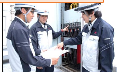
保守・メンテナンス工事
