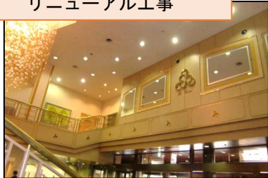
リニューアル工事
