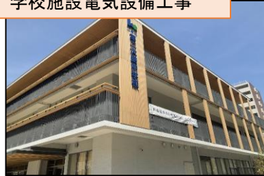
学校施設電気設備工事
