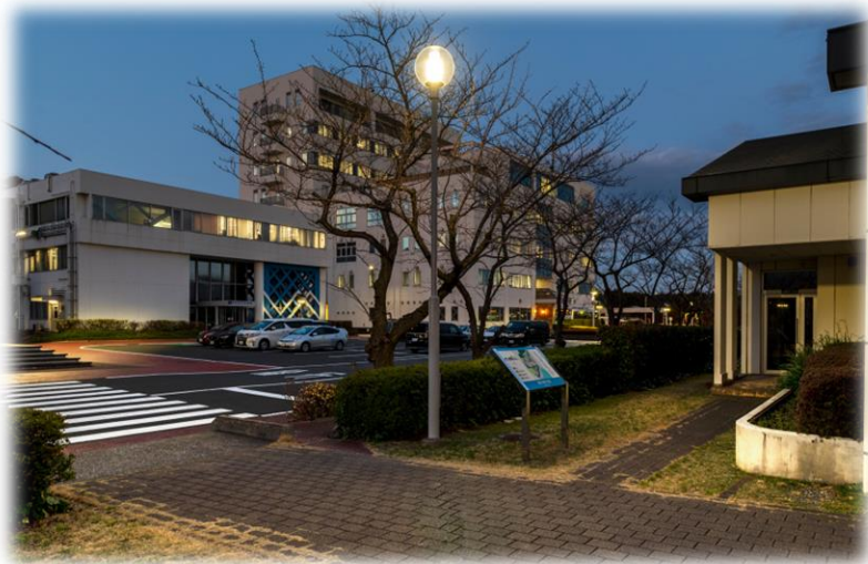
海洋研究開発機構 外灯改修 歩道植栽
