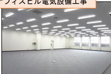
オフィスビル電気設備工事
