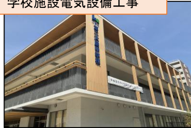
学校施設電気設備工事
