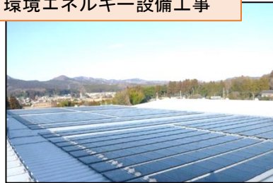
環境エネルギー設備工事
