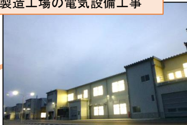
製造工場の電気設備工事
