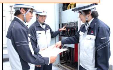
保守・メンテナンス工事
