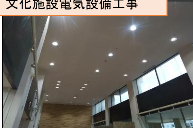
文化施設電気設備工事
